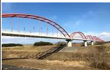
折り返し地点から見える荒川水管橋 －全長は1100 m、日本最長の水管橋
